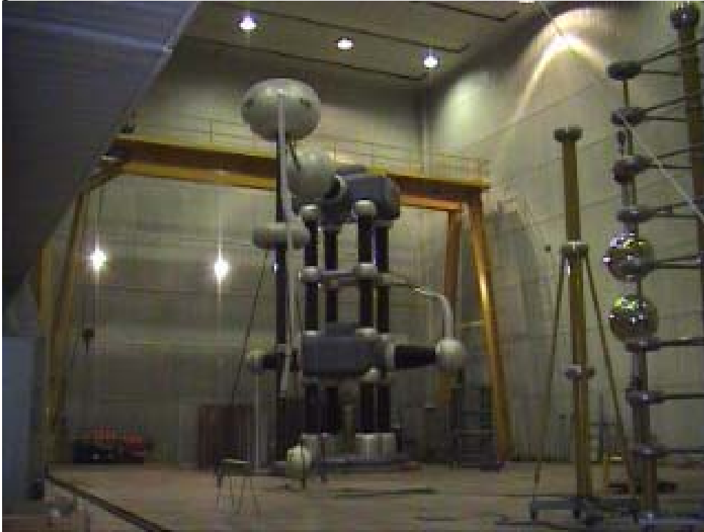
fig.1 - Trasformatore bistadio SIEMENS e divisore di tensione capacitivo e spinterometro a sfere
