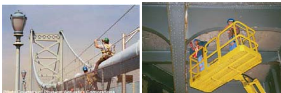
Figura 2.1. Ispezioni di ponti con tecniche NDT.
