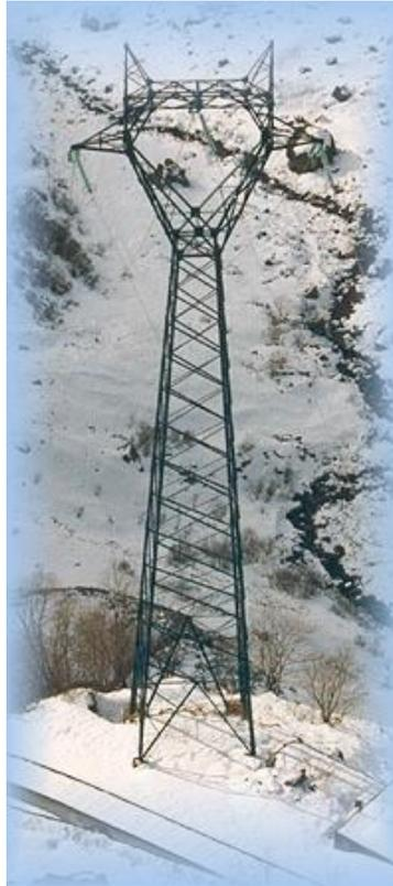
Figura 3.12: traliccio di sostegno per linea a 380 kV, in configurazione a singola terna.
