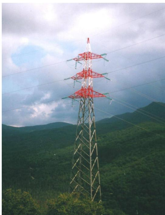
Figura 3.11: traliccio di sostegno per linea a 150 kV, in configurazione a doppia terna.
