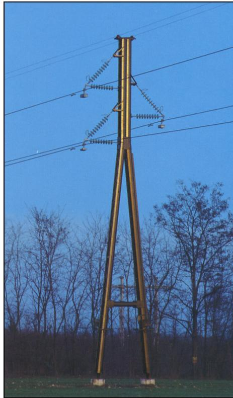
Figura 3.15: linea aerea compatta con sostegno a cavalletto.
