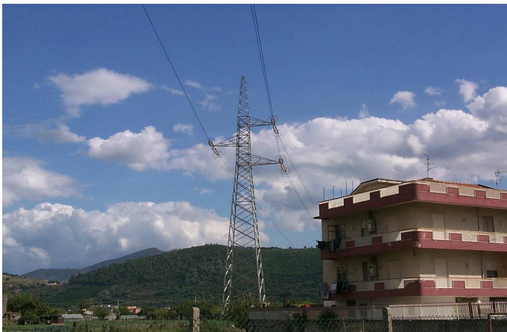
Figura 3.10: traliccio di sostegno a singola terna, per linea a 150 kV.
